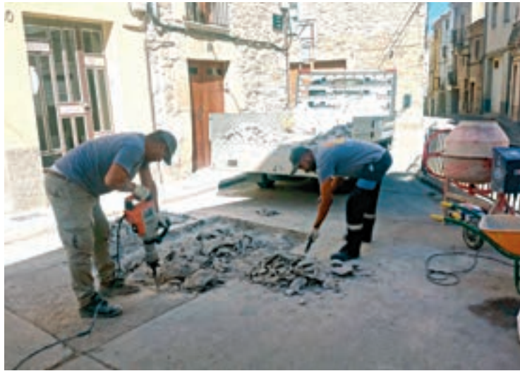
FOTO_ Aj. Tàrraga Operaris treballant en la millora de la pavimentació en espais urbans del barri del Castell
