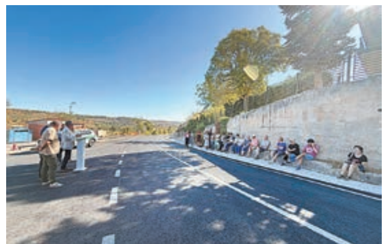
FOTO_DdL. Tarn va visitar ahir les obres a Nalec
