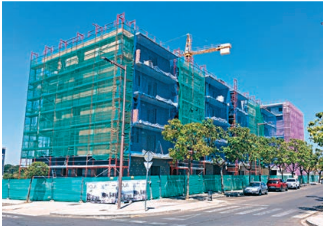
FOTO_ D.A. Estat actual d'un edifici en obres a l'avinguda Fontanet, a la Bordeta
