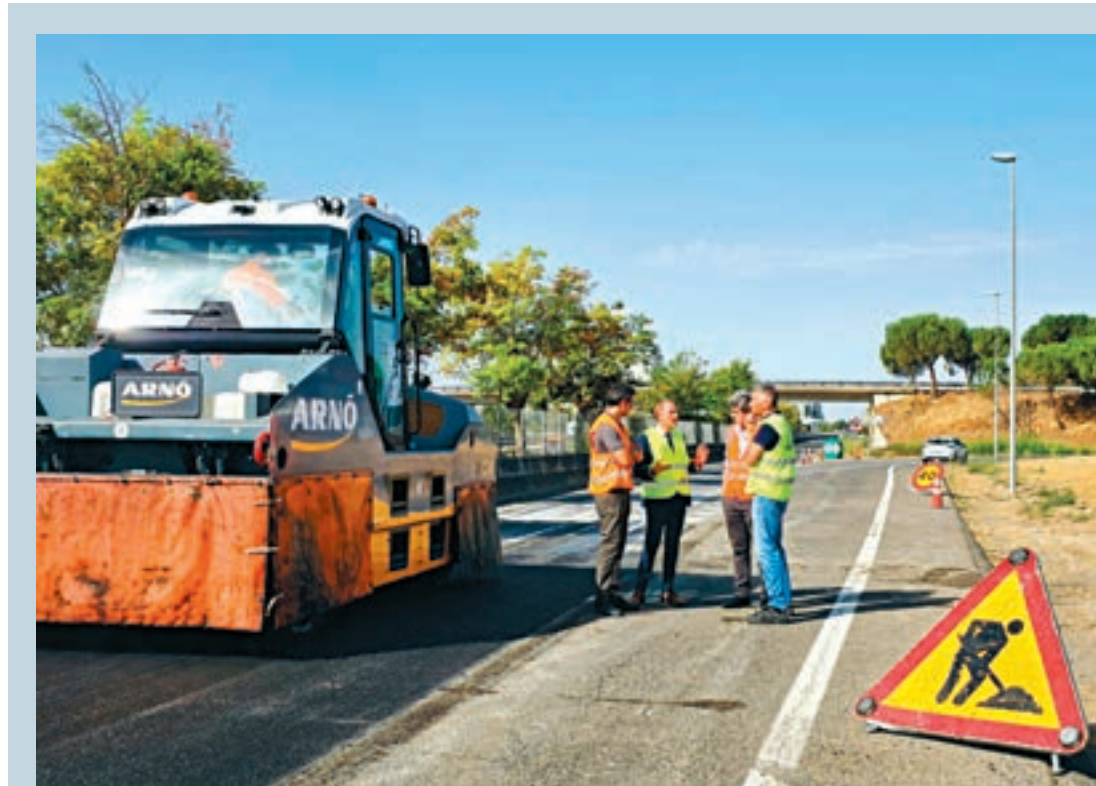
FOTO_Subdelegació Crespín durant la seva visita als treballs de reparació del ferm
