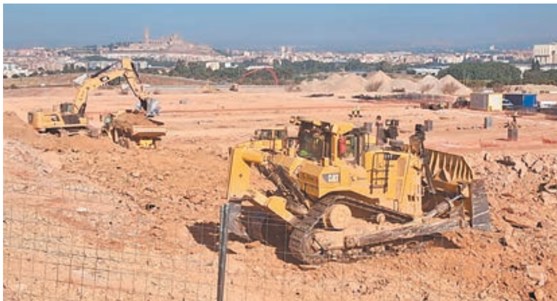
FOTO_ D.A. Maquinària pesant a la zona alta del futur parc comercial
