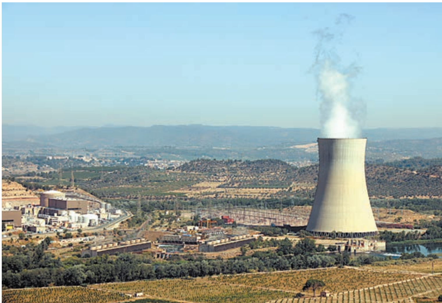
FOTO_ Roger Segura (ACN) La central nuclear d'Ascó, a la ribera d'Ebre, amb la xemeneia fumejant a la dreta
