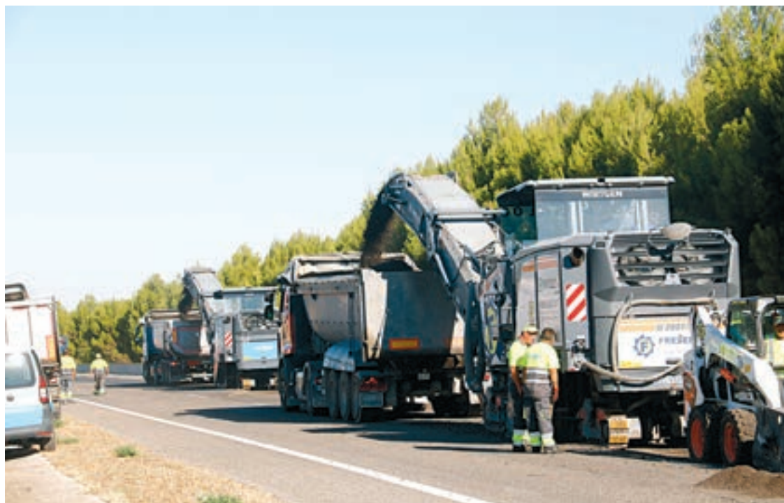
FOTO_ACN El ministeri també ha iniciat les obres a l'A-2 a la Segarra
