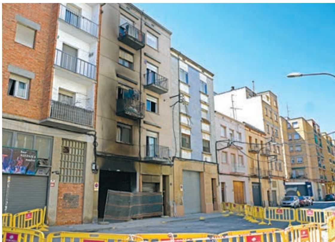
FOTO_ Núria García Estat de l'edifici actualment, amb les tanques perimetrant-lo
