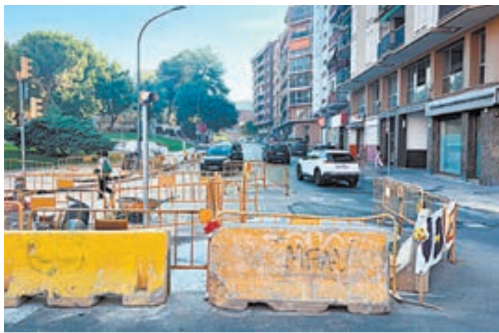
FOTO_ RafaPMedina Estat actual de les obres
