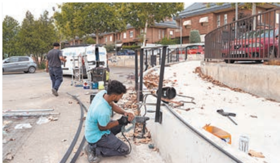
FOTO_ Jorge Agustín Uns operaris instal·len la barana de la rampa
