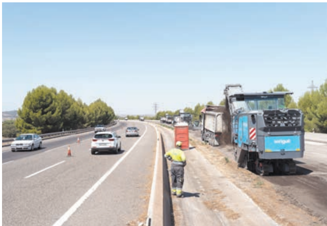
FOTO_ Jorge Agustín Màquines treballant en la rehabilitació del ferm a l'A-2 a la Segarra
