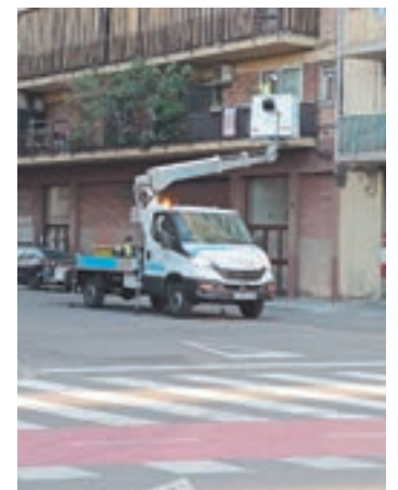
FOTO_ L.M. Operaris en una grua arreglen el cable
