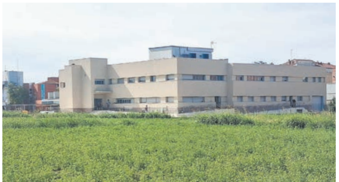
FOTO_ D.A. Imatge de l'estat de les obres a l'edifici, ja sense cap estructura metàl·lica
