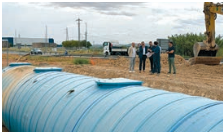
FOTO_ Aj. Alcarràs Visita a les obres de la depuradora
