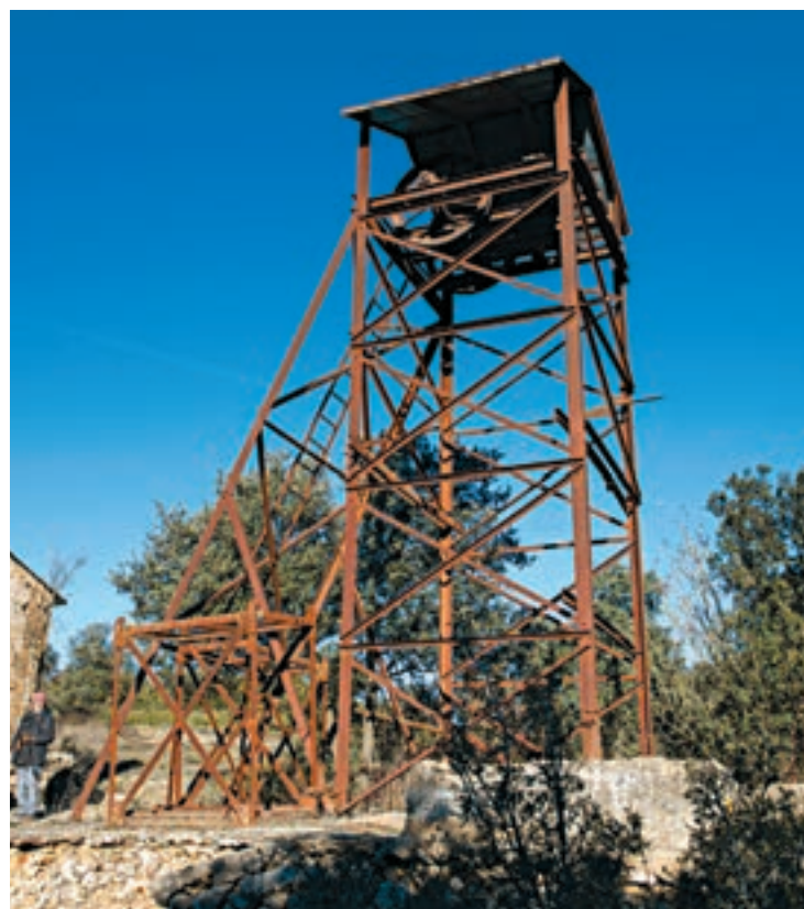
FOTO_PCAPE Instal·lacions de la mina Teresa I
