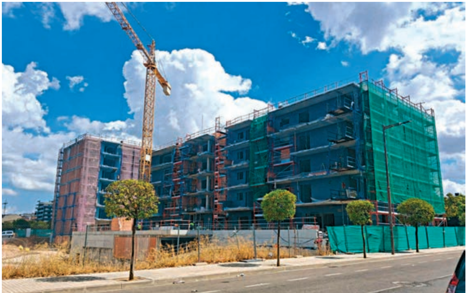
FOTO_ D.A. Imatge d'un edifici en construcció al barri de la Bordeta, a la ciutat de Lleida
