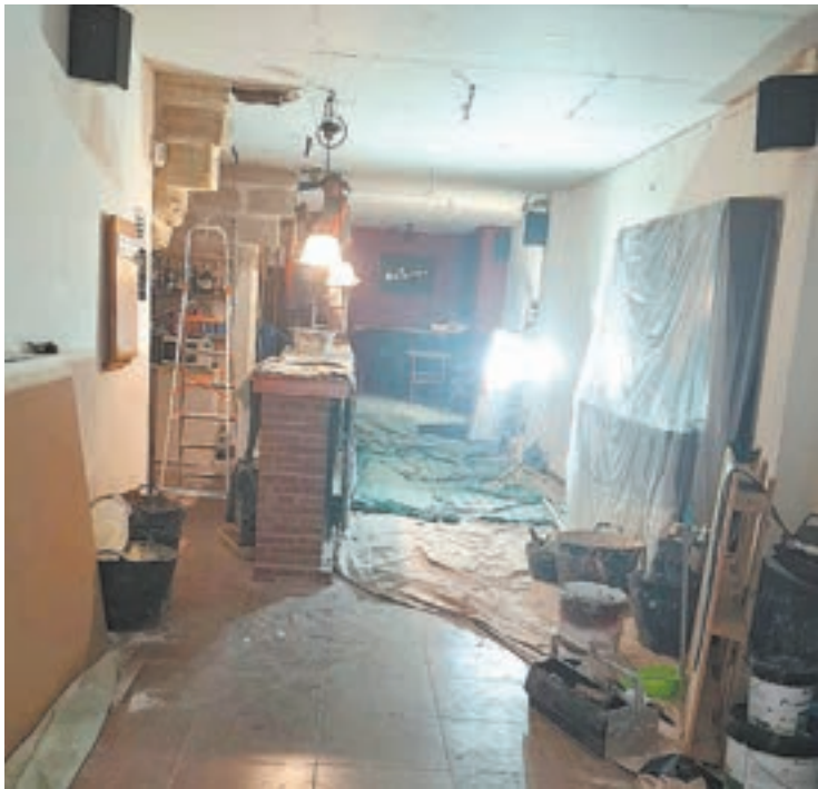
FOTO_ L.M. Les obres a l'Antares, les quals segons fonts avancen de pressa, de cara a la pròxima obertura
