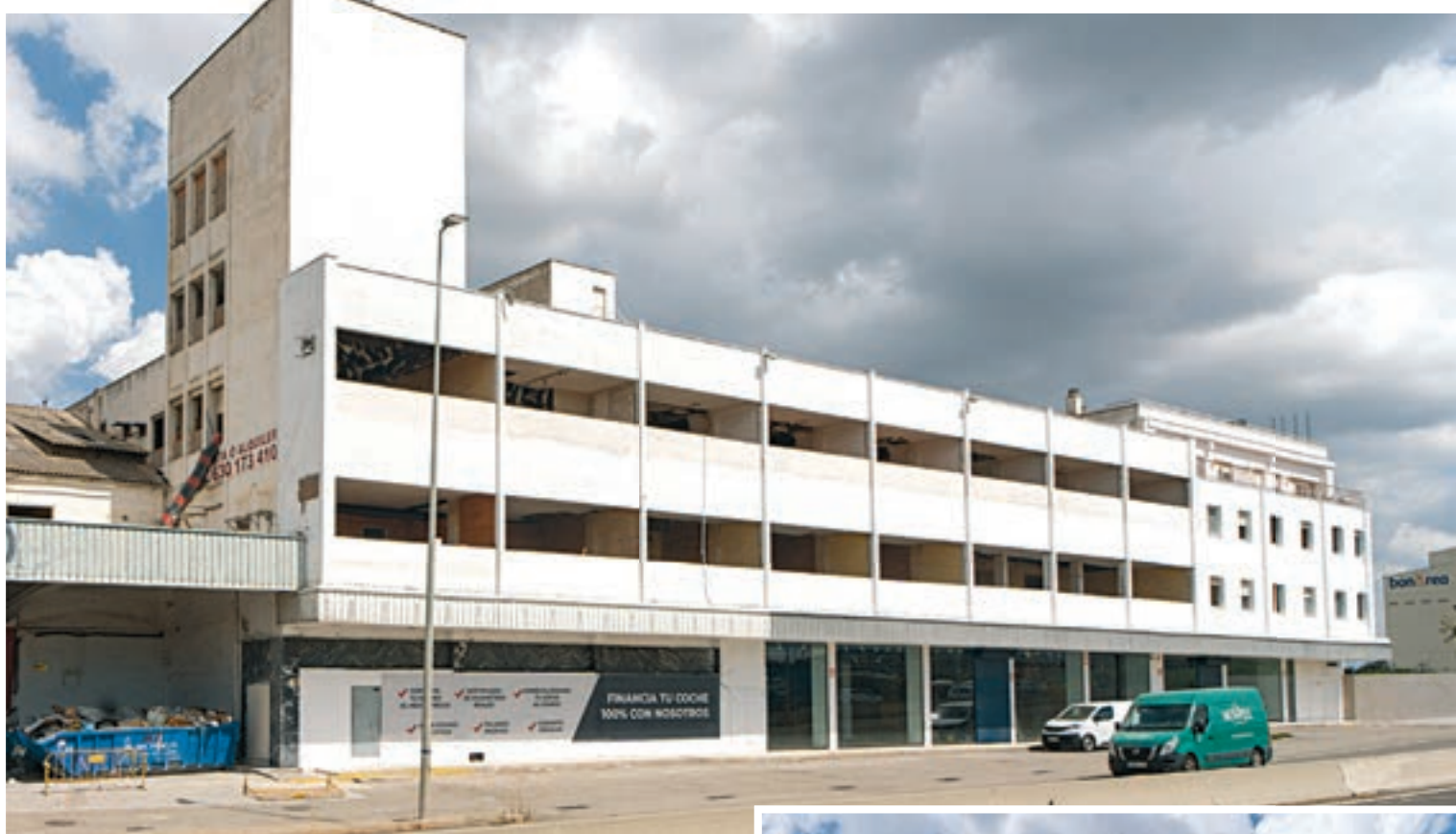
FOTO_ Jorge Agustín Refoma de la façana de l'antic hotel Ilerda, a la carretera LL-11
