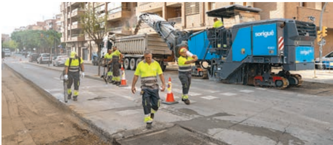
FOTO_ Jorge Agustín Uns operaris treballen en la reposició del nou ferm
