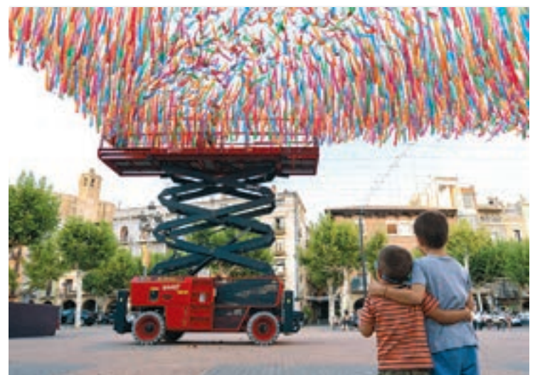
FOTO_Jorge Agustín Instal·lació del sombreat a la plaça
