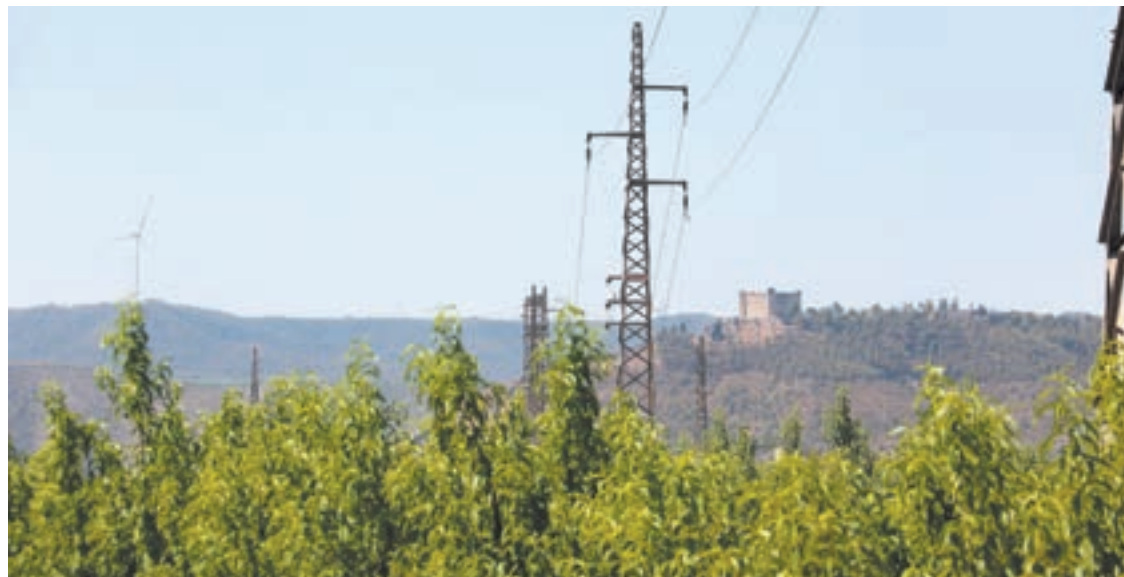
FOTO_ ACN Imatge d'una línia elèctrica que va de Mequinensa a la Granja d'Escarp
