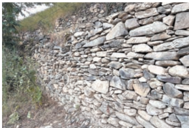
FOTO_CGA Eth pressupòst a estat de 12.388 èuros
