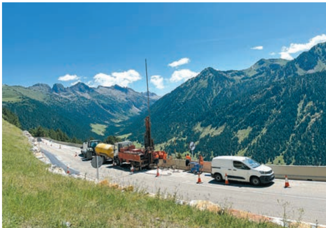
FOTO_ ACN Treballs al punt de la C-28 afectat per moviments del terreny
