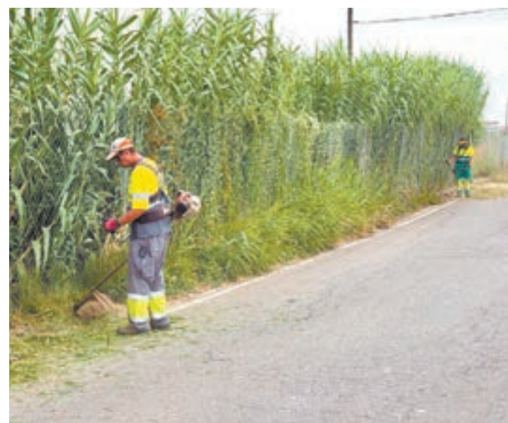
FOTO_ RafaPMedina Dos treballadors ahir al matí talen la vegetació amb maquinària en aquest camí
