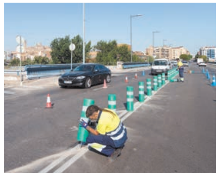
FOTO_ Jorge Agustín Els operaris instal·len les pilones per dividir en dos el Pont de Pardinyes
