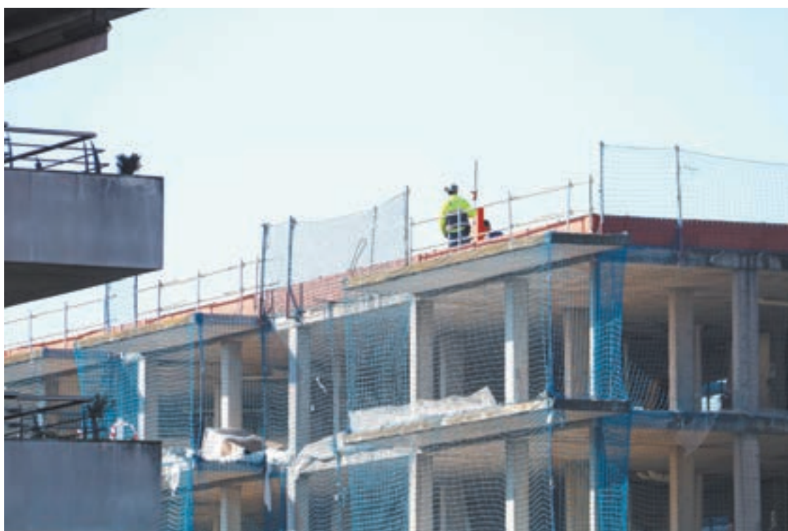
FOTO_ ACN Un operari a la teulada d'un pis en construcció a Lleida
