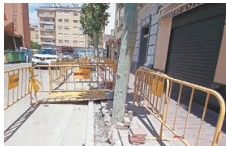
FOTO_ Endesa Imatge de les obres per millorar la xarxa
