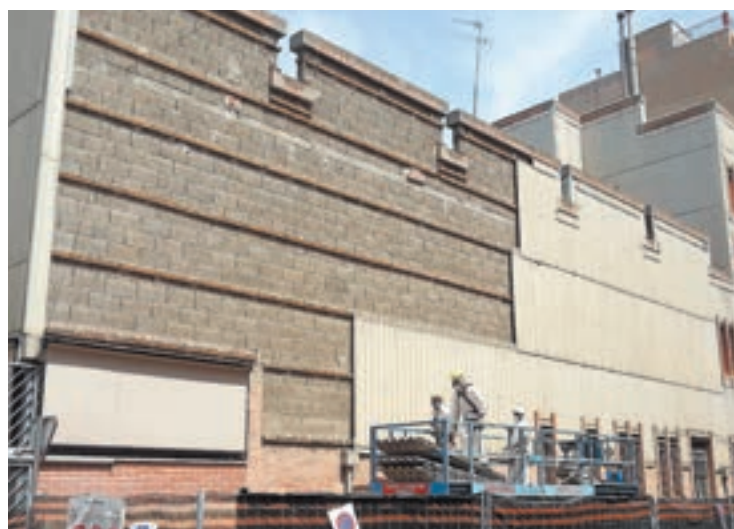
FOTO_ Premsa Bisbat de Lleida Treballadors retirant el fibrociment i ‘operaran’ en uns 1.057 metres quadrats
