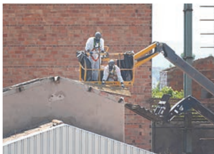
FOTO_ L.M. Treballadors retiren amiant d'una coberta
