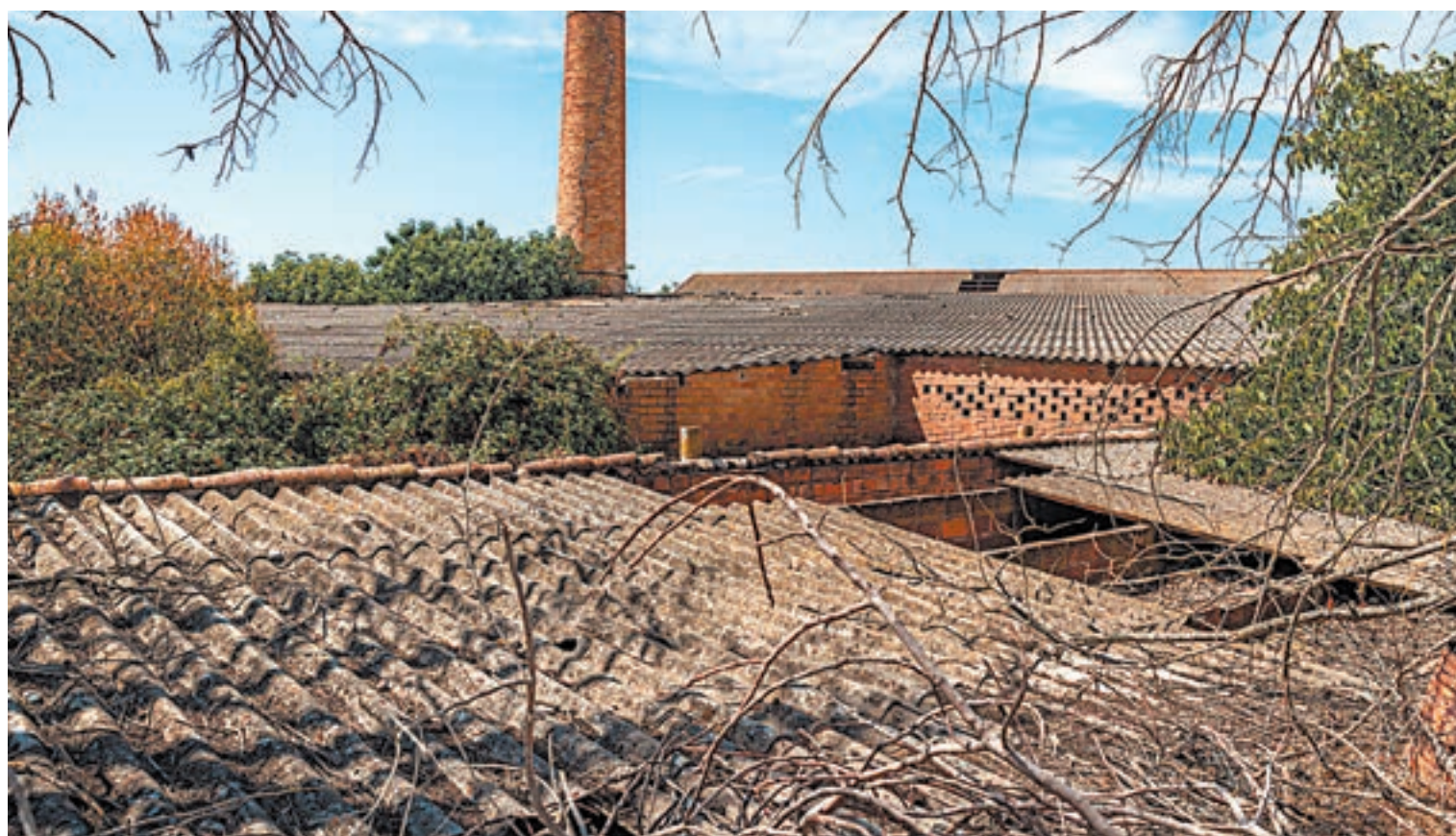
FOTO_ Fran Echevarría L'antiga bòbila Monné és un dels exemples d'edificis amb fibrociment de Lleida
