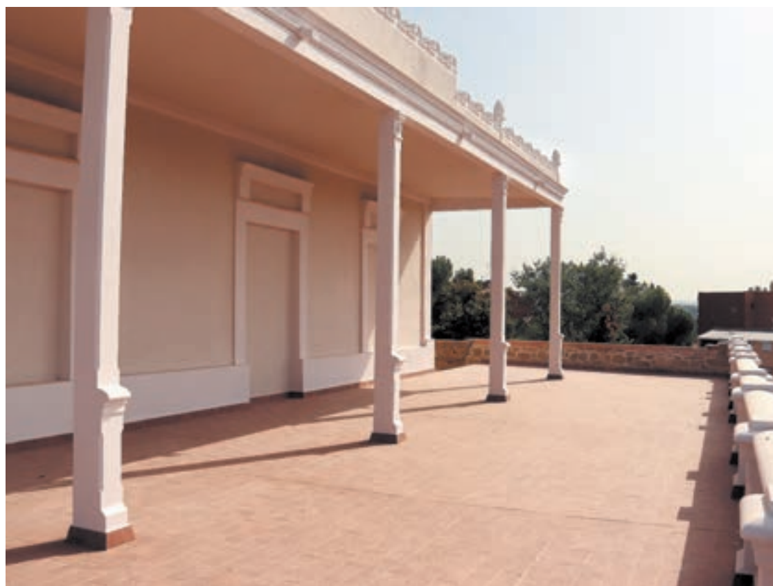
FOTO_ Oriol Bosch (ACN) La terrassa rehabilitada de Torre Vicens, al Secà de Sant Pere, l'edifici modernista del segle XIX, donat per Rosa Vicens el 1937 a la Diputació
