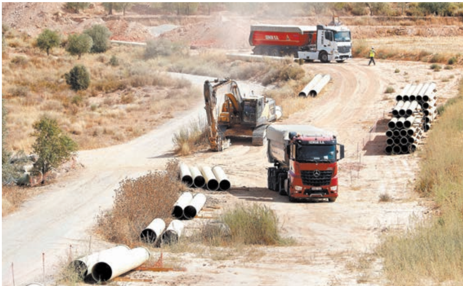
FOTO_ACN Obres de xarxa per instal·lar una canonada als sectors 10, 11 i 14 del canal Segarra-Garrigues
