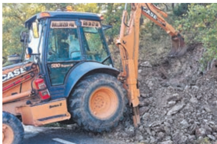
FOTO_Diputació Una màquina treballant a la zona
