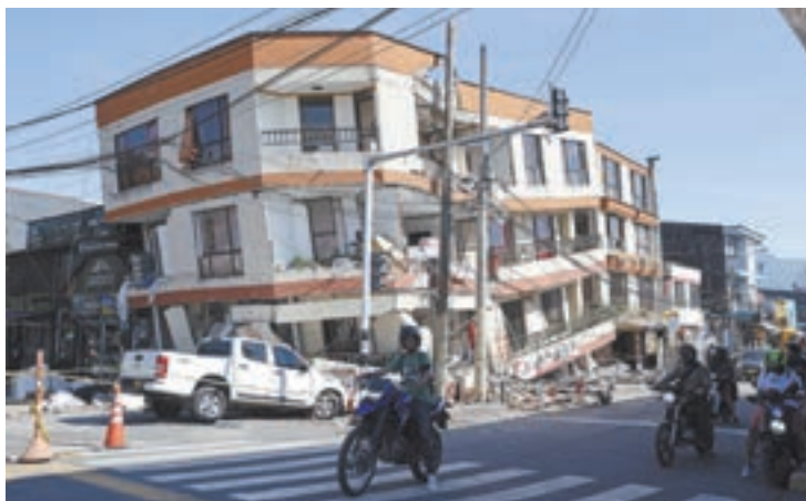
FOTO_ Carlos Ortega (EFE) Un edifici a punt d'ensorrar-se després del terratrèmol a Colòmbia
