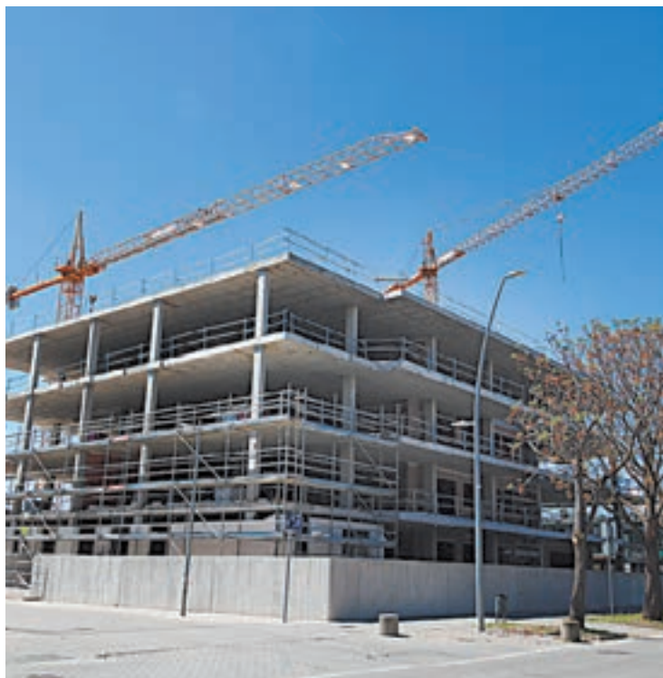
FOTO_ Roger Segura (ACN) Imatge d'un edifici en construcció a l'avinguda de Ciutat Jardí, a Lleida ciutat
