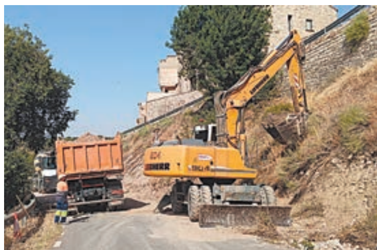
FOTO_ Diputació Màquines i operaris treballant
