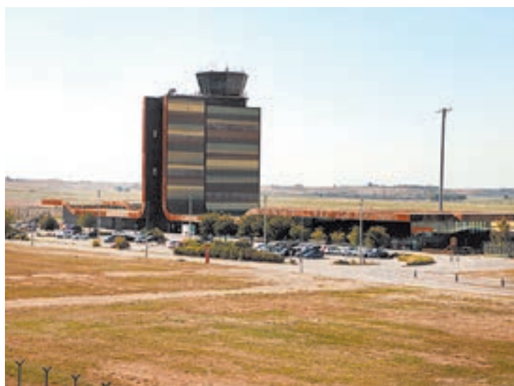
La terminal i la torre de control de l'aeroport de Lleida-Alguaire FOTO_ACN
