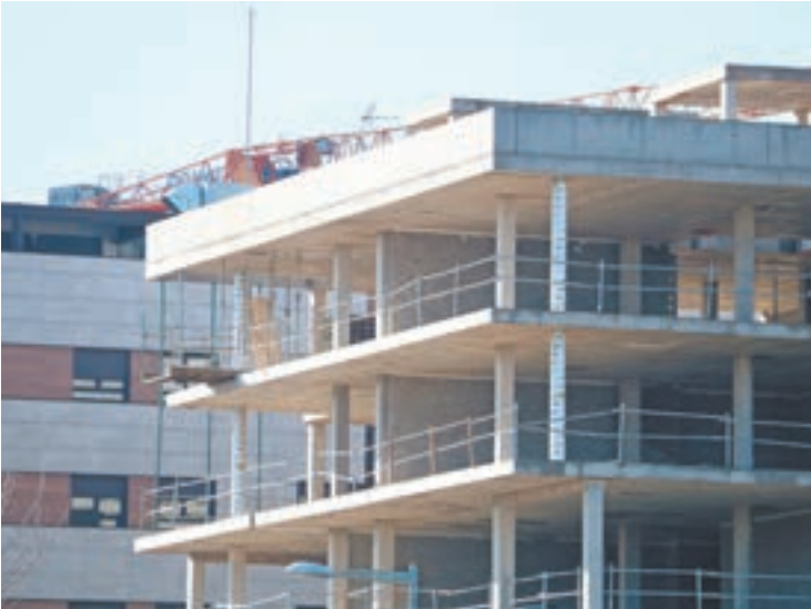
FOTO_ ACN Un bloc de pisos en construcció a Lleida
