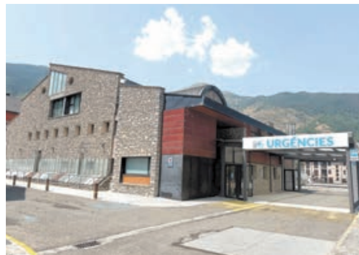
FOTO_ CGA Imatge de l'exterior del centre hospitalari
