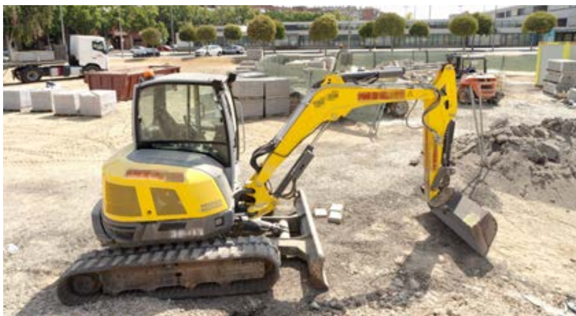
FOTO_ Jorge Agustín La màquina excavadora aparcada ahir al barri de Pardinyes
