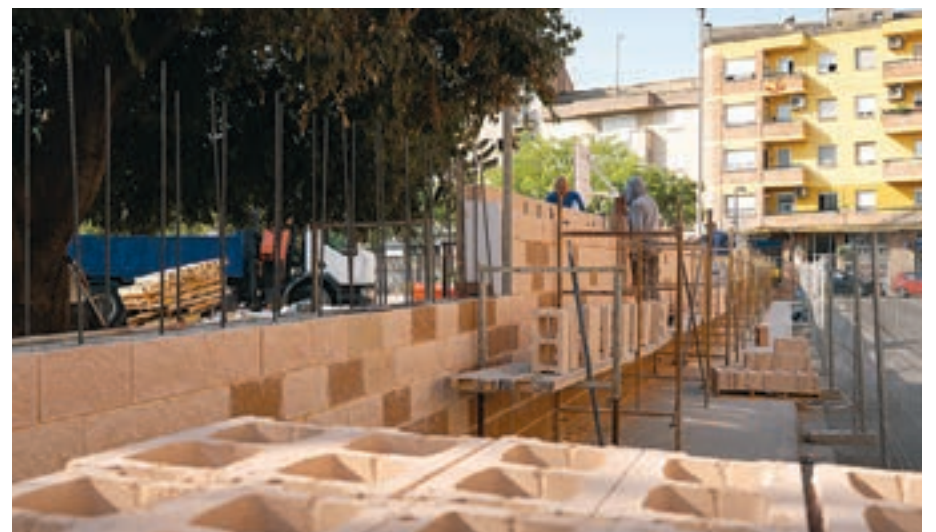
FOTO_ Jorge Agustín Treballs del nou mur del centre escolar
