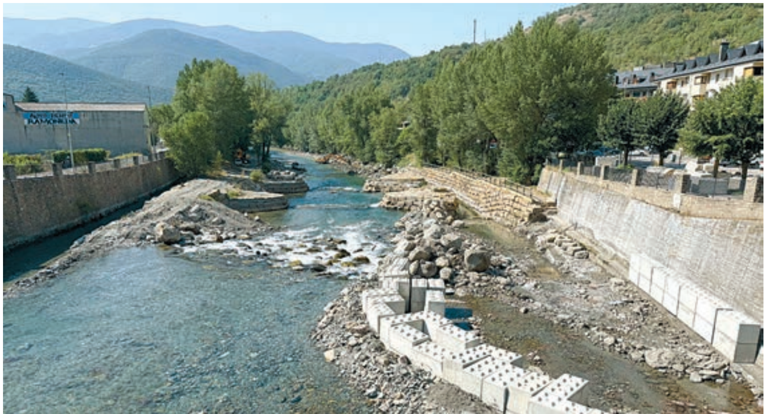
FOTO_Marta Lluvich (ACN) Tram del riu Noguera Pallaresa on s'està construint l'Estadi Lliure de Caiac, a Sort
