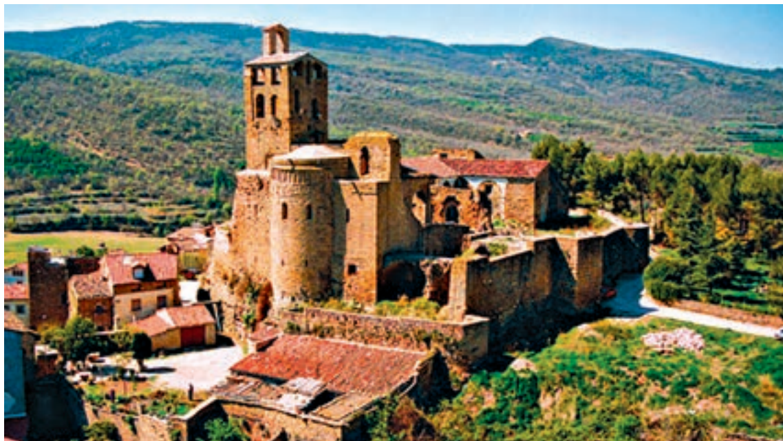
FOTO_ Diputació de Lleida El camí de la muralla serà un altre dels espais a rehabilitar
