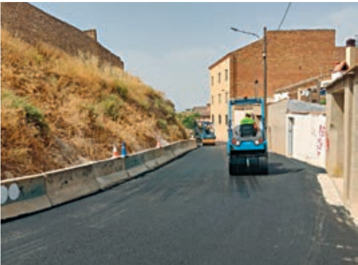
FOTO_ Aj.Tàrrega El carrer del Mur del Castell s’ha asfaltat deixant de ser un camí de terra
