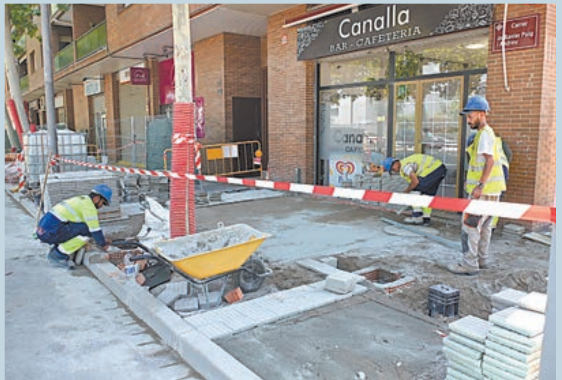
FOTO_ Núria García Treballadors renoven la vorera d'aquests carrers del barri
