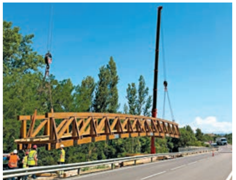
FOTO_Diputació Tècnics instal·lant la passarel·la de fusta
