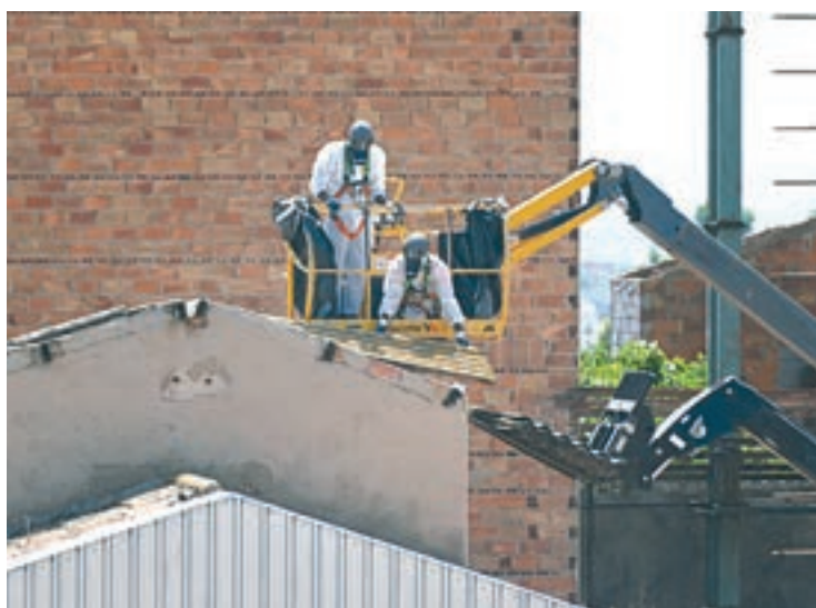
Imatge d'arxiu de la retirada d'amiant d'una coberta de la ciutat de Lleida
