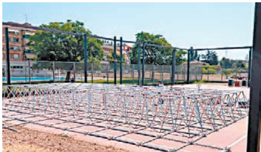
FOTO_ AAVV Bordeta Estructura metàl·lica de la coberta
