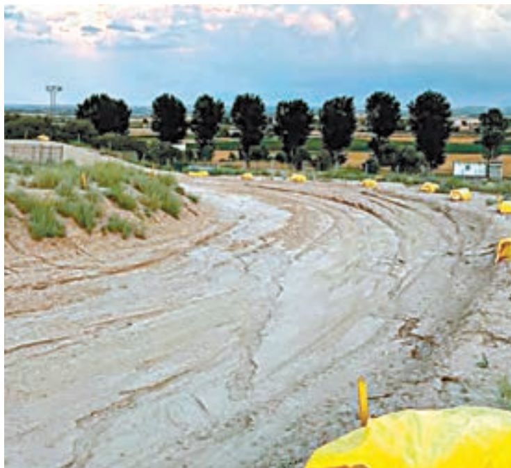
FOTO_ C. M. B. Caldrà recondicar les instal·lacions
