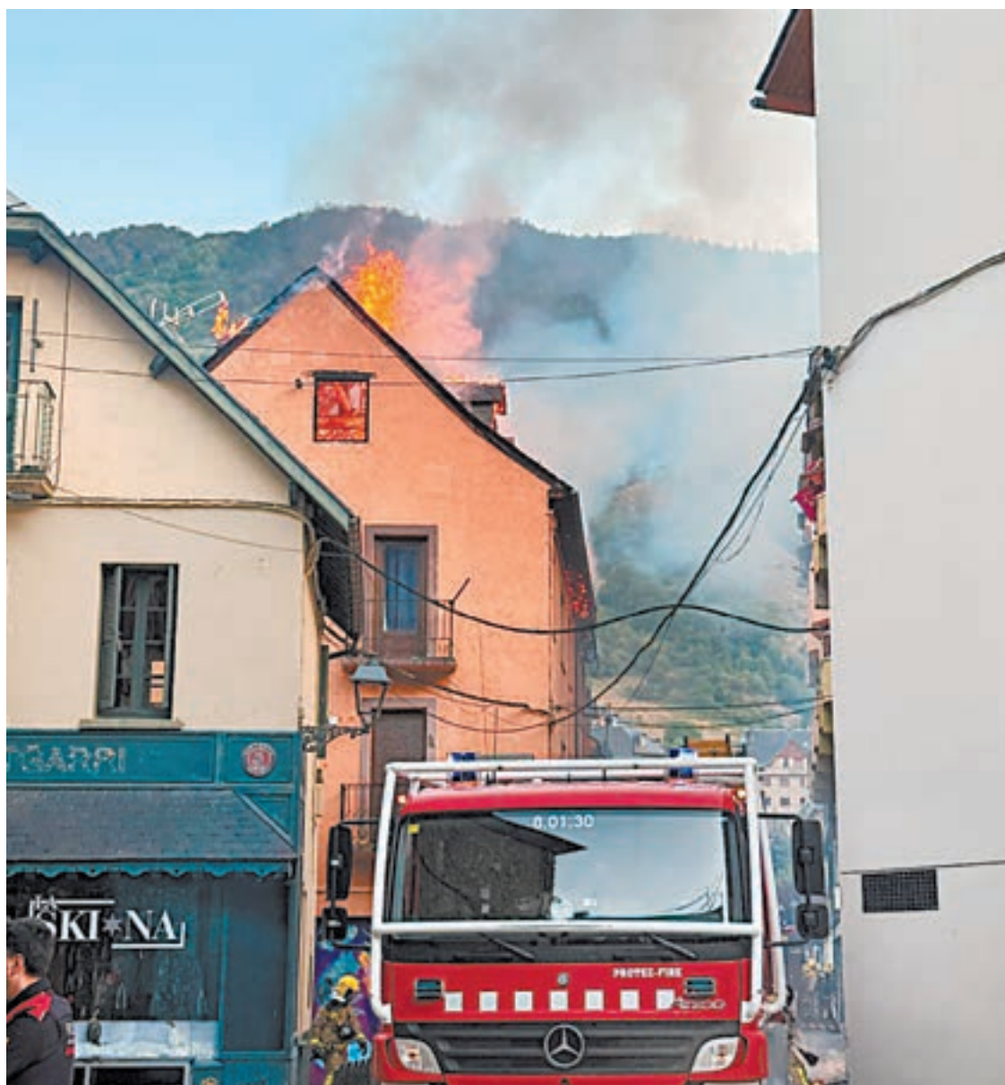
FOTO_ L.M. Imatge de l'incendi declarat en un edifici del carrer Anglada
