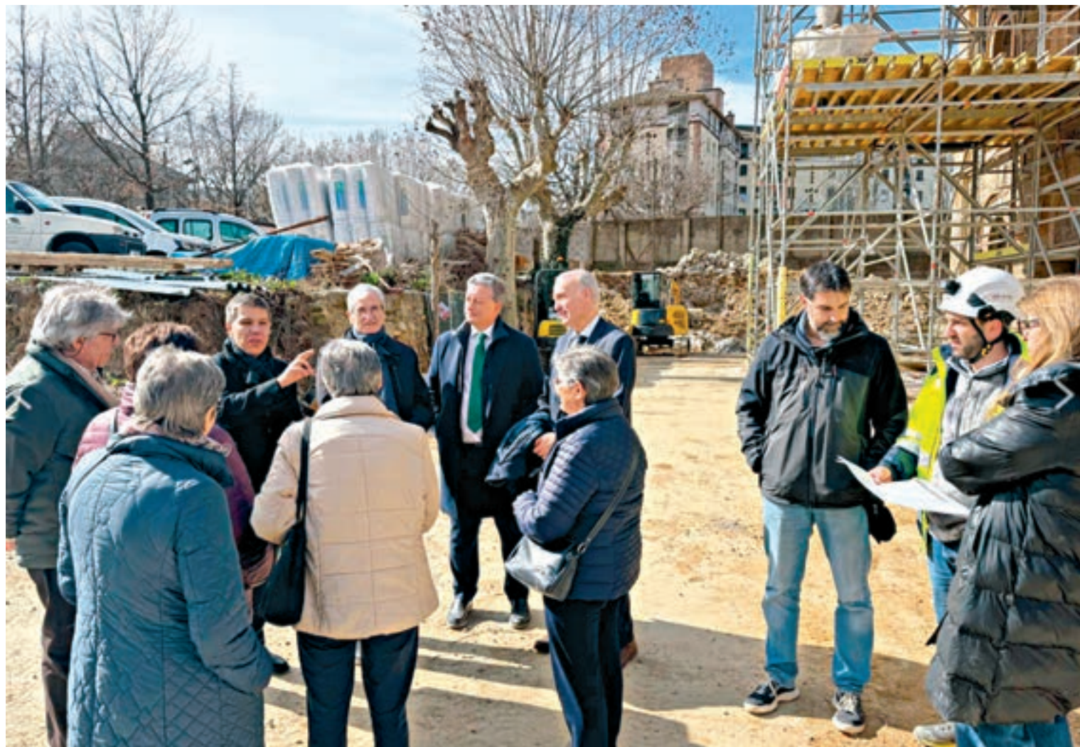
FOTO_ Bisbat d'Urgell Visita de les autoritats a les obres de construcció del futur Centre de Salut Mental Sant Lluís
