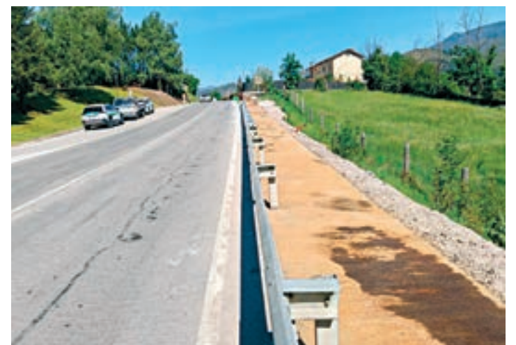
FOTO_ Diputació Imatge del tram on s'ha actuat
