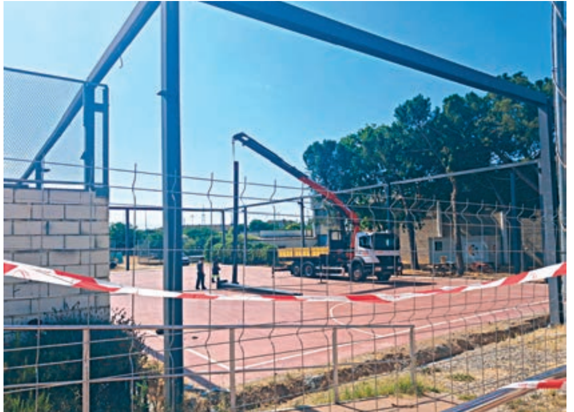
FOTO_ D.A. Tasques de retirada de l'antiga estructura de la coberta danyada
