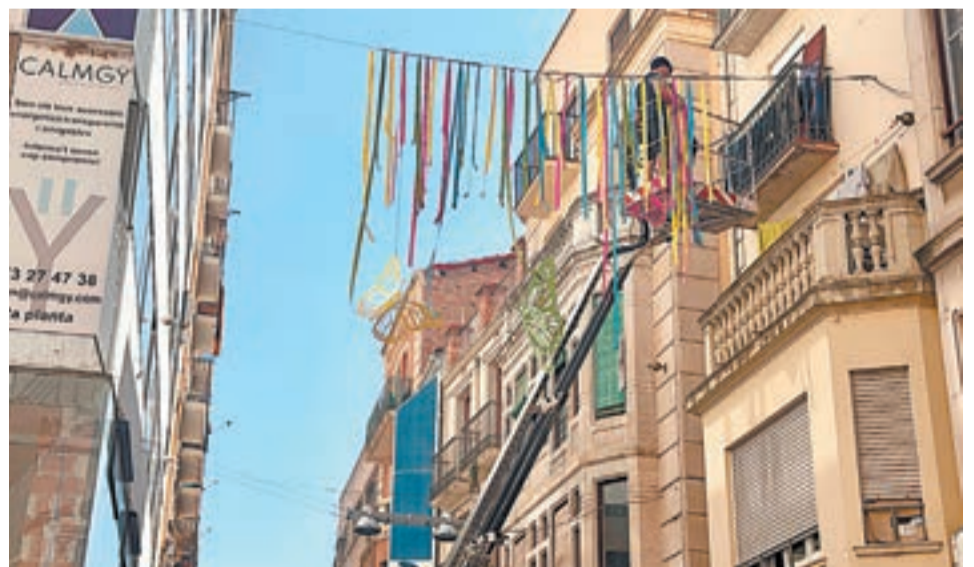
FOTO_ RafaPMedina Operaris treballen en la nova decoració
