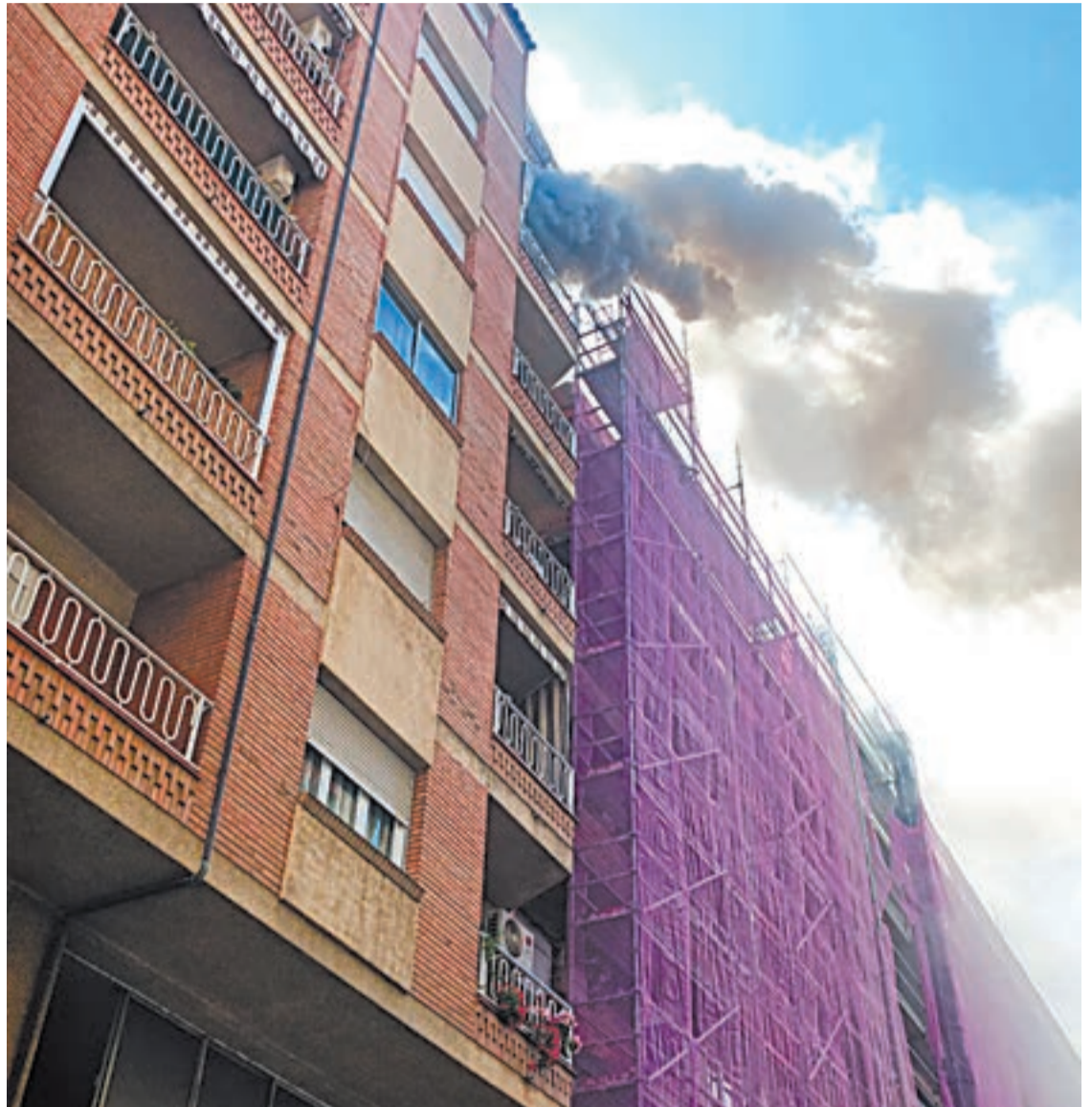
FOTO_Paeria Columna de fum sortint pel balcó del cinquè pis de l'edifici
