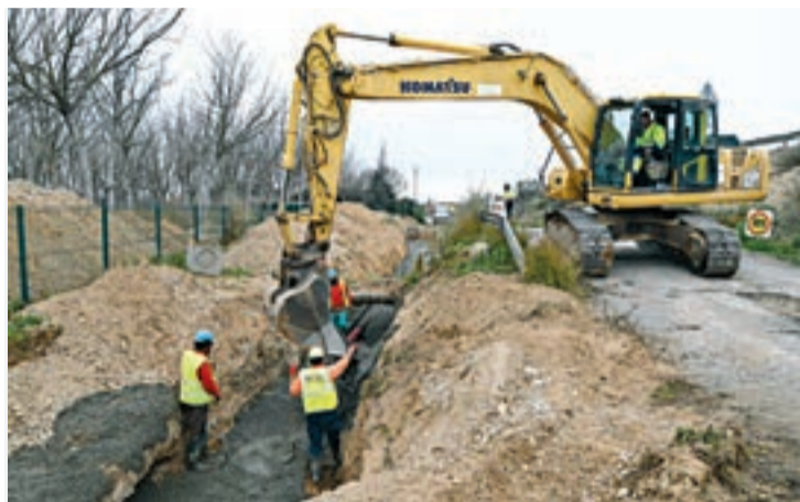
FOTO_L.M. Obres polèmiques de la nova MAT a l'Horta
