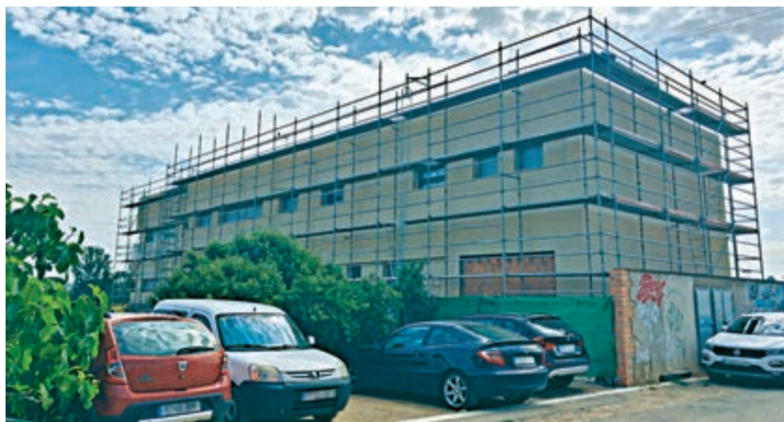
FOTO_D.A. Obres a l'exterior de l'edifici, que s'ubica a la Bordeta
