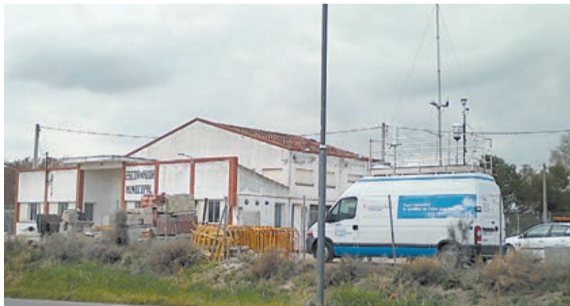
FOTO_Gencat Imatge d'arxiu d'una estació de mesurament mòbil a les Borges
