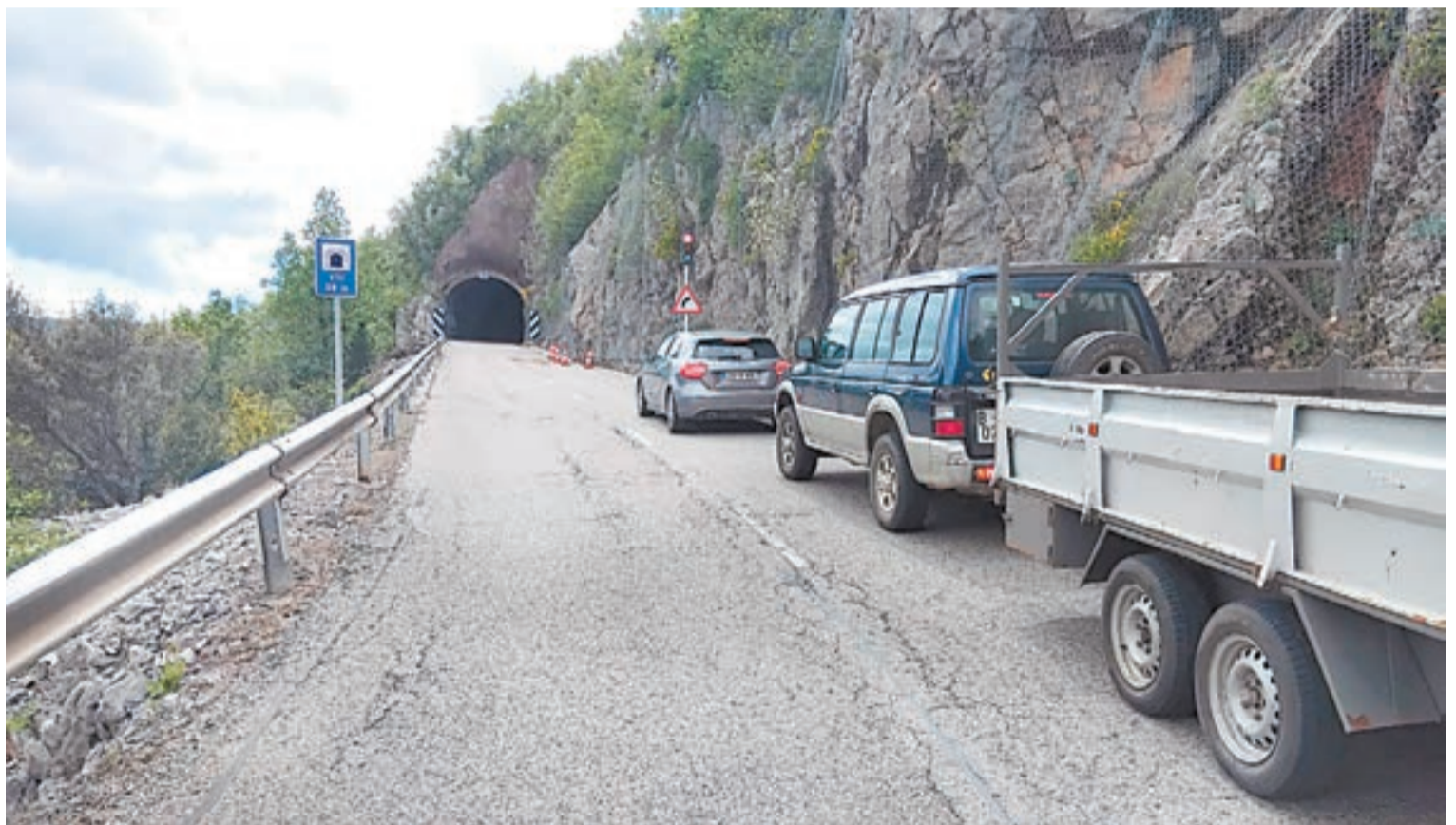
FOTO_L.M. Vehicles a la carretera N-260 després de les tasques de neteja que es van dur a terme a la calçada
