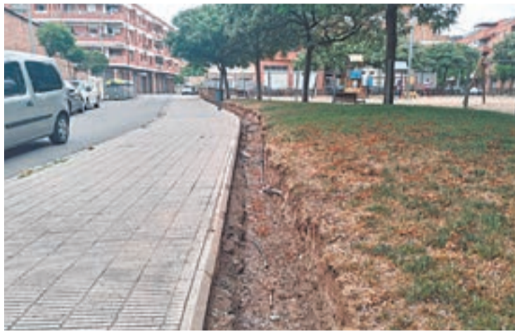
FOTO_D.A. Una de les rases on es ficaran tanques
