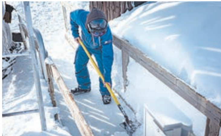
FOTO_ACN Un operari retirant neu a un dels accessos a un remuntador a Port Ainé
