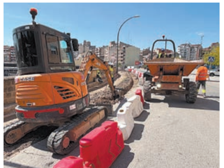
FOTO_ La Paeria Operaris renovant el tram de vorera
