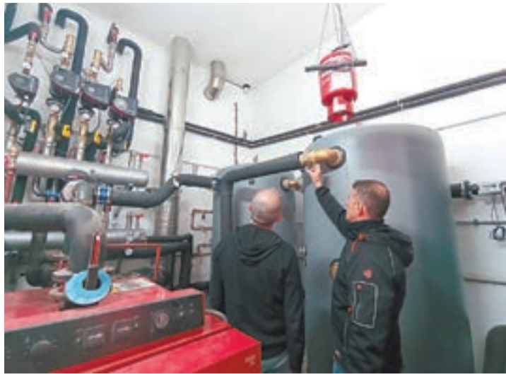
FOTO_ Aj. Agramunt Tècnics acabant la instal·lació
