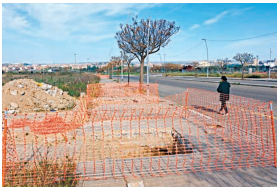
FOTO_D.A. Sondatges a terra previs a les obres de construcció del parc comercial
