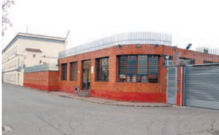
FOTO_ L.M. Exterior de l'edifici del Centre Penitenciari Ponent de Lleida, al barri de Ciutat Jardí
