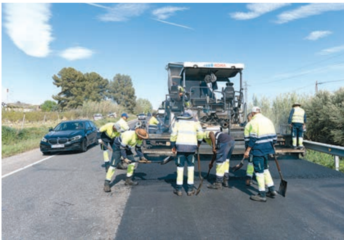
FOTO_Jorge Agustín Operaris en les tasques de pavimentació de la carretera
