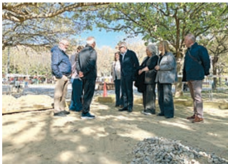
FOTO_ La Paeria Visita a les obres de reforma
