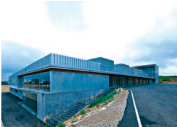
FOTO_Paeria L'edifici abans dels futurs canvis
