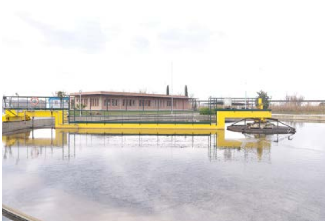
FOTO_ Jorge Agustín Imatge de la depuradora de Lleida, que és clau en el procés
