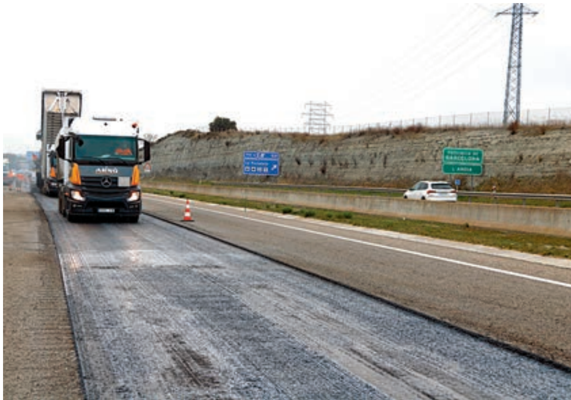
FOTO_ ACN Imatge de les obres de millora del ferm a l'A-2 entre Cervera i la Panadella
