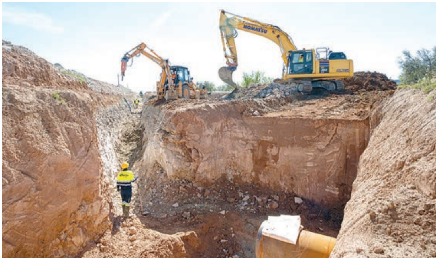
FOTO_ Jorge Agustín Màquines i operaris treballant a les obres de la xarxa de distribució del Segarra-Garrigues a les Borges
