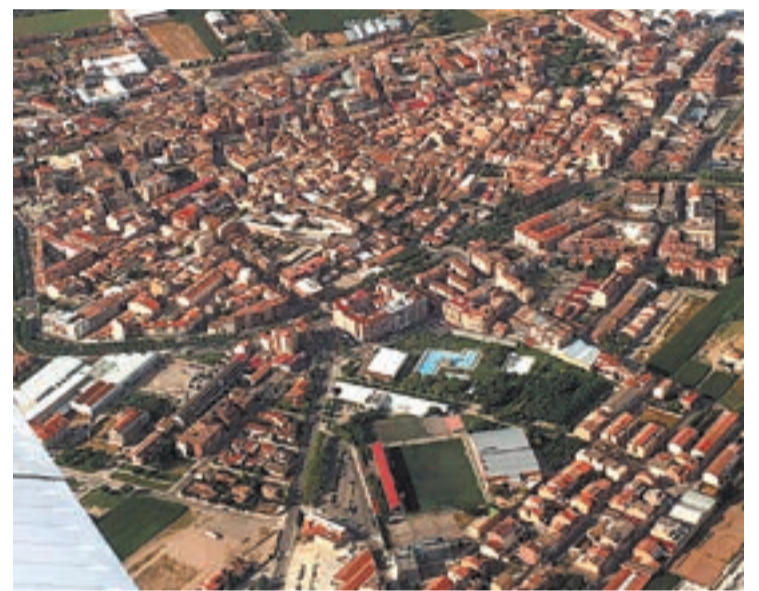
Josep A. Pérez Vista Piscina coberta i Pavelló Poliesportiu
