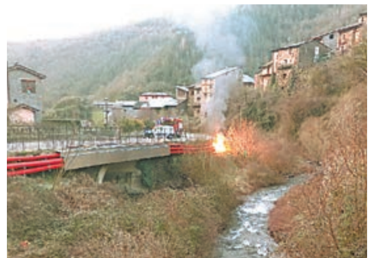
FOTO_ Bombers Incendi a la línia d'alta tensió
