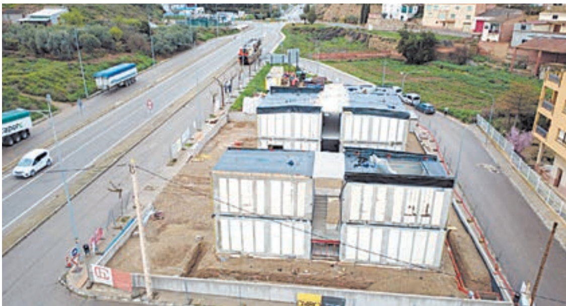
FOTO_Ajuntament de Seròs Els 15 mòduls del nou equipament instal·lats
